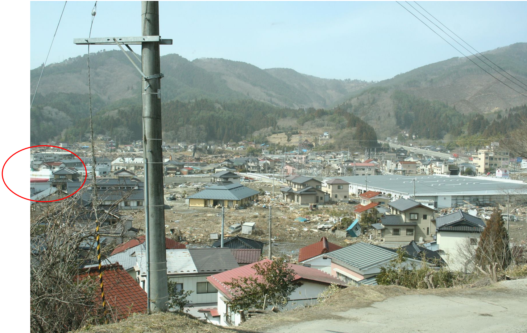
火災の酷かった鹿折地区の最上流部。山腹の45号バイパスまで津波。 丸で囲んだのは船。津波と共に船が建物をなぎ倒していったという地元証言あり。
