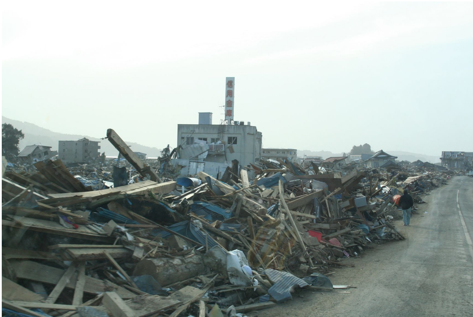
松岩地区に降りる。旧道を挟んで海から山腹まで何も残っていない。
